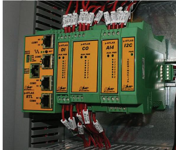
piko Atlas®-RTL (ili kraće pAtlas-RTL) obavlja funkciju koncentratora podataka i konvertora protokola u cilju povezivanja različitih segmenata DCS-a, a takođe i obrade podataka prikupljenih od I/O modula i podređenih (slave) uređaja u realnom vremenu korišćenjem PLC algoritama kreiranih po IEC 61131-3 standardu.
