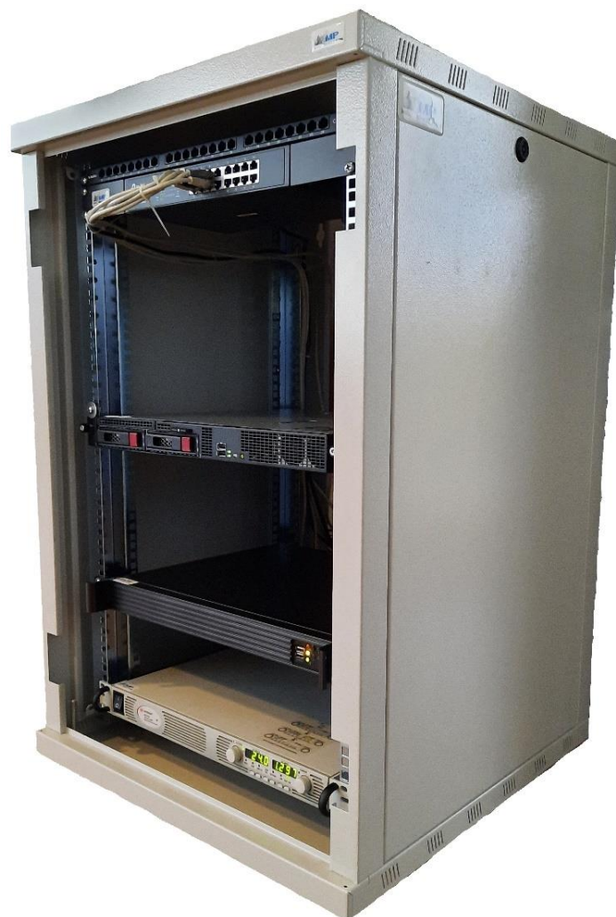
Слика 3. Рек орман са свим елементима Д-РДЦ система (осим диспечерског пулта)
