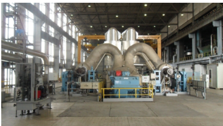
Slika 1 - Parna turbina bloka TEKO B2, 350 MW
