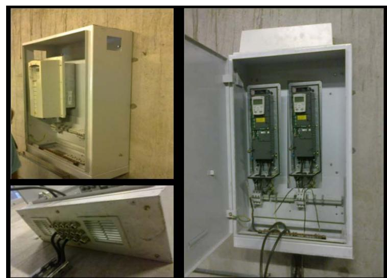
Slika 15: Prikaz elektroupravljačkog razvodnog ormana sa frekventnim regulatorima
