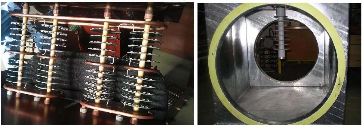
Slika 10: VN ispravljač (slika levo) i VN izolator smešten u VN komori (slika desno), preko koga se generiše visoki napon 100kVDC
