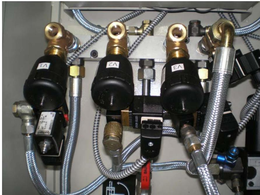
Sl.9. Izgled upravljačkih pilot ventila PVI-PV3
