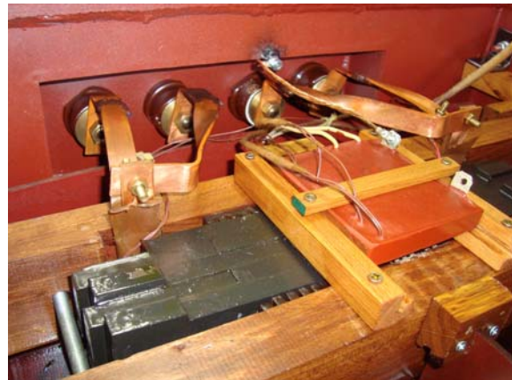
Sl.14. Način montaže i mesto ugradnje mernog elektronskog modula za merenje napona i struje ESI, (a)-ugradnja u transformatorski sud VNVF ispravljača za pobudu ESI, (b)-izgled mernog modula nakon zalivanja
