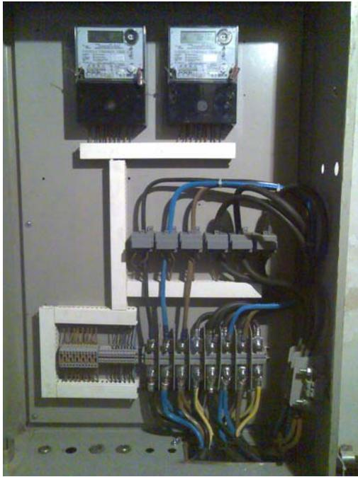
Sl.6. Unutrašnjost mernog ormana sa pripadajućim mernim grupama MG1 i MG2 za merenje utroška aktive i reaktivne energije VF i 50Hz-nog sistema ESI
