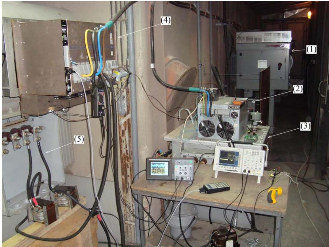
**Sl.4. Izgled realizovanog VF postrojenja ESI na TE "Morava";** 1-Rezonantni pretvarač 3x0.4kV, 50Hz/70kV DC, radne učestanosti 10kHz, prividne snage 70kVA (2kom.), 2- VF pretvarač sa naponskom PWM 3x0.4kV, 50Hz/70kV DC (1 kom.), 3-VNVF transformator podizač napona 0.4 kV/70kV, radne učestanosti 10 kHz, 4-Strujno regulisani pretvarač prilagođen za 50Hz-ni transformator, 3x0.4kV,50Hz/70kV DC, prividne snage 70kVA 5- Postojeći VN transformator učestanosti 50Hz, 0.4/55kV, prividne snage 55 kVA.
