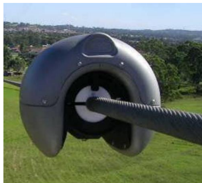
Слика 2 – ОТЛМ сензорска јединица инсталирана на проводнику далековода
