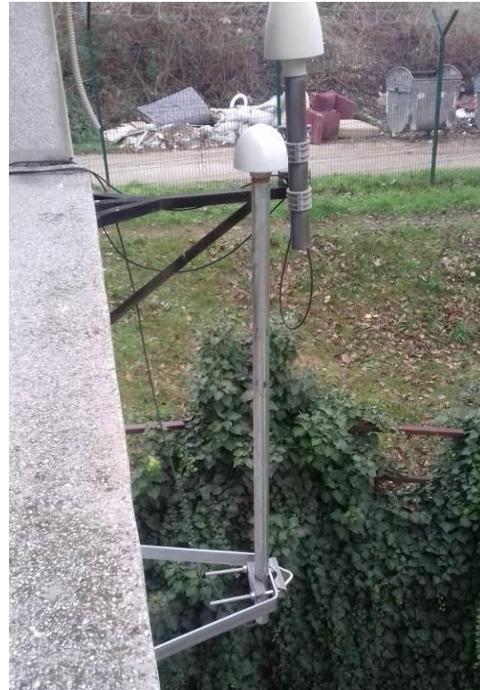
Слика 3 Примери инсталираних спољашњих GPS антена
