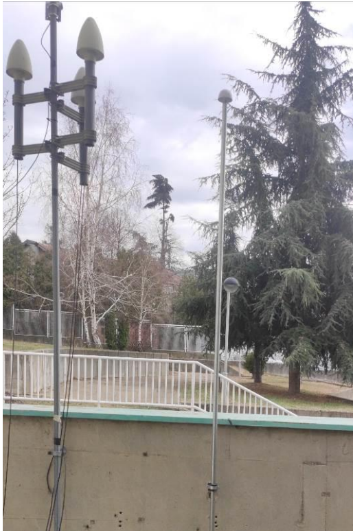
Слика 3 Примери инсталираних спољашњих GPS антена
