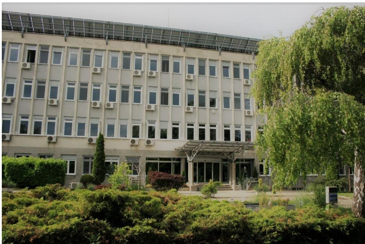
**Glavna zgrada Instituta Mihajlo Pupin na Zvezdari, Volgina 15, zidana u periodu 1961-1963. sa fotonaponskom elektranom snage 50 kW na krovu, puštenom u rad 20.09.2013.**
