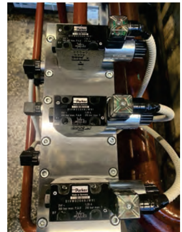
Слика 7 – Примена ТЦимп блока на парној турбини
